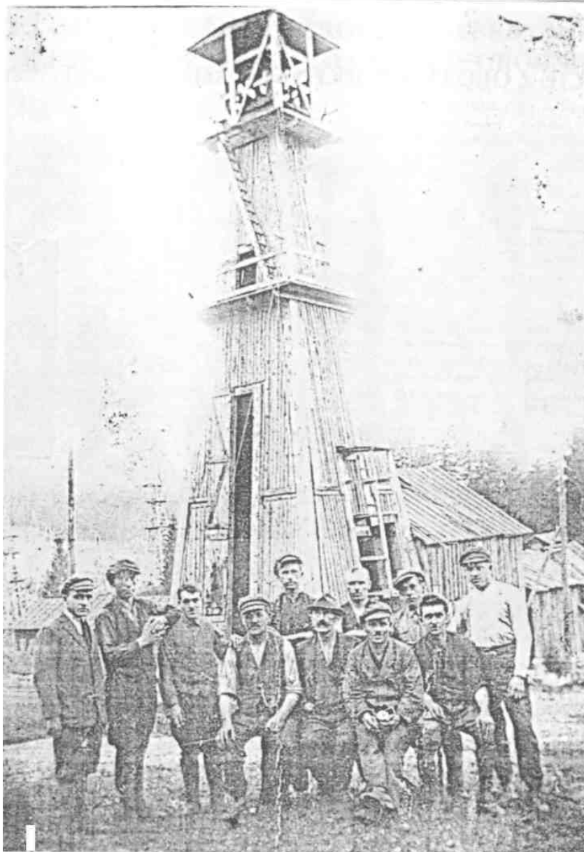
Schodnica - Szyb wiertniczy ropy naftowej (w Schodnicy takich szybów było około 300)
