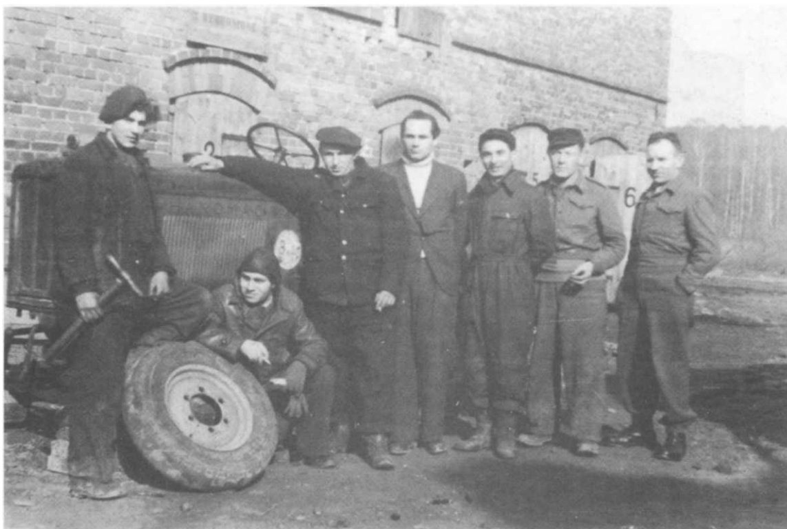
Na budowie elektrowni wodnej „Wały Śląskie”
