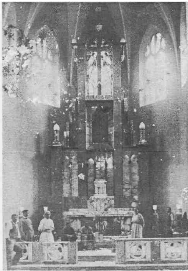
Myszków koło Krakowa - renowacja ołtarza płytkami alabastrowymi przez łukowian.
